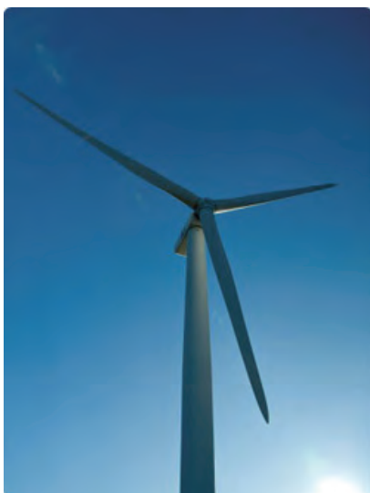
番屋風力発電所
